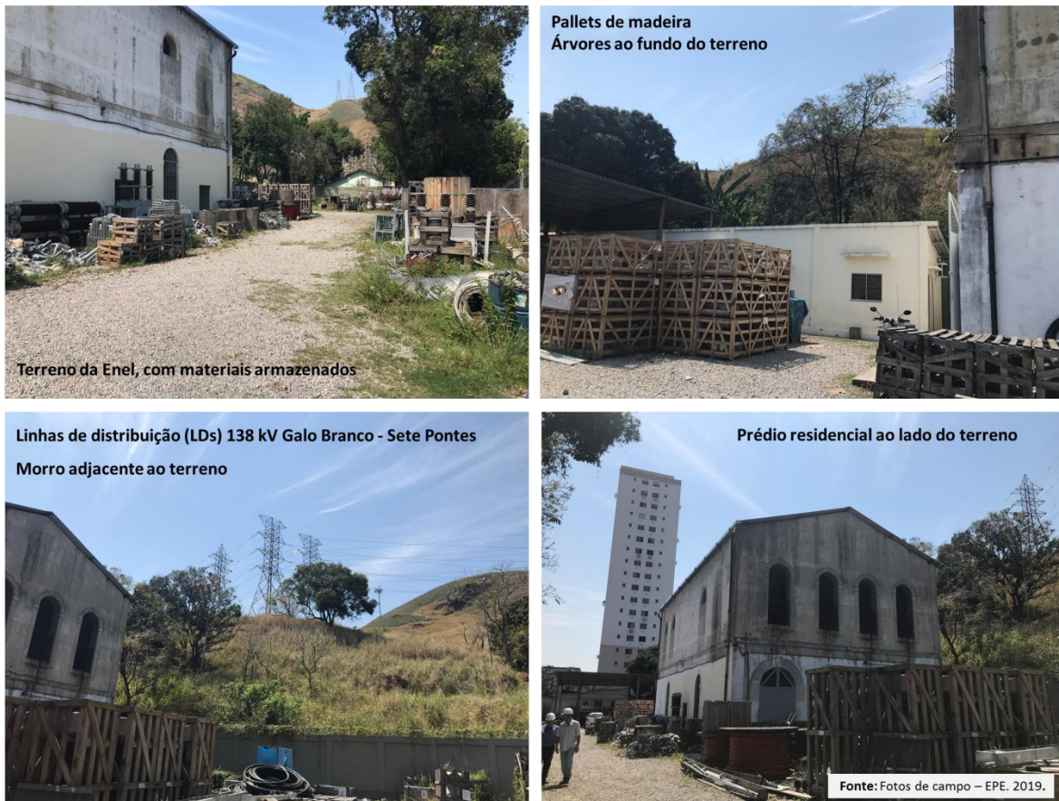
Figura 3 – Fotos do terreno Covanca, indicado para a construção da nova subestação
