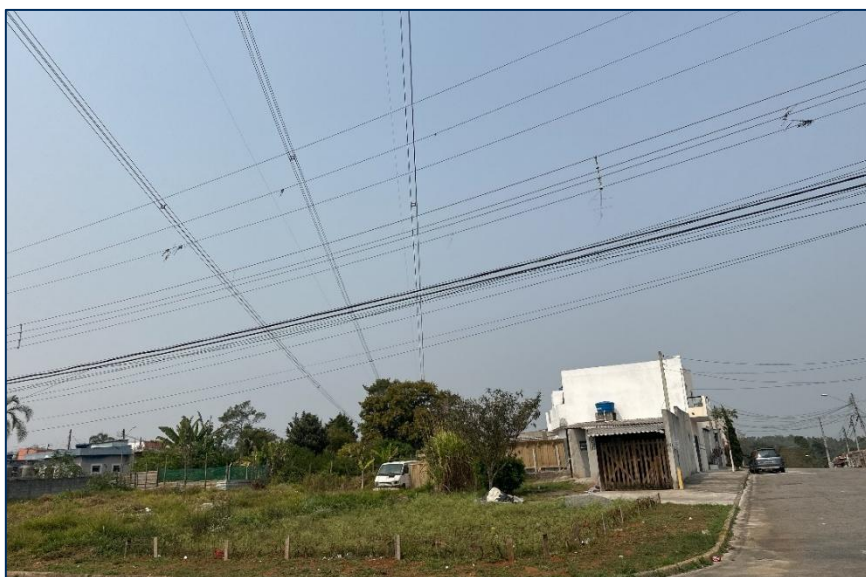
Figura 18 – Edificações situadas ao lado da faixa de servidão de LT 440 kV Santo Ângelo - Solvay C1, inviabilizando opção de rota estudada
