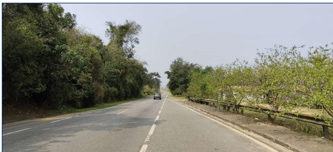
Figura 19 – Ponto de restrição de espaço físico para passagem de linha na rodovia estadual SP-039
