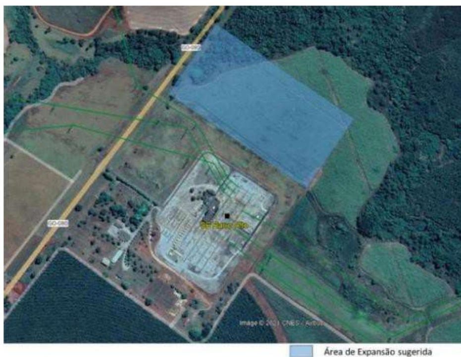
Figura 1 – Espaço reservado para pátio 500 kV planejado da SE Barro Alto
