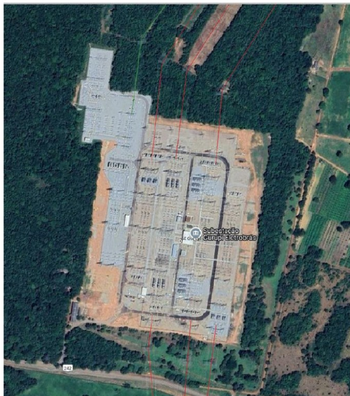
Figura 2 – SE Gurupi 500/230 kV
