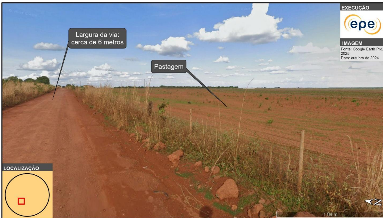
Figura 9 – Detalhe da rodovia MT-100, sem pavimentação asfáltica na pista
