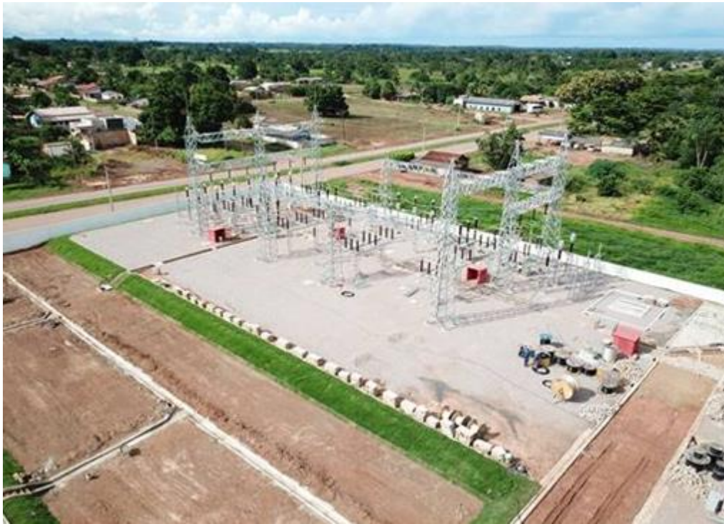
Figura 1 – Subestação Alvorada d’Oeste 138 kV/13,8 kV em fase de conclusão
