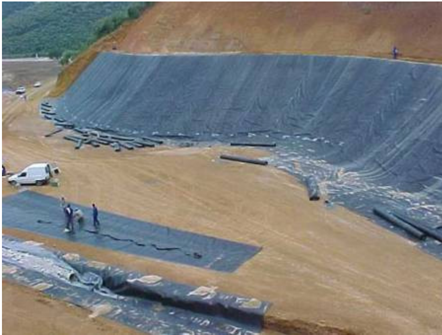
Figura17 – Aplicação do Revestimento no Aterro de Adrianópolis, Nova Iguaçu, RJ
