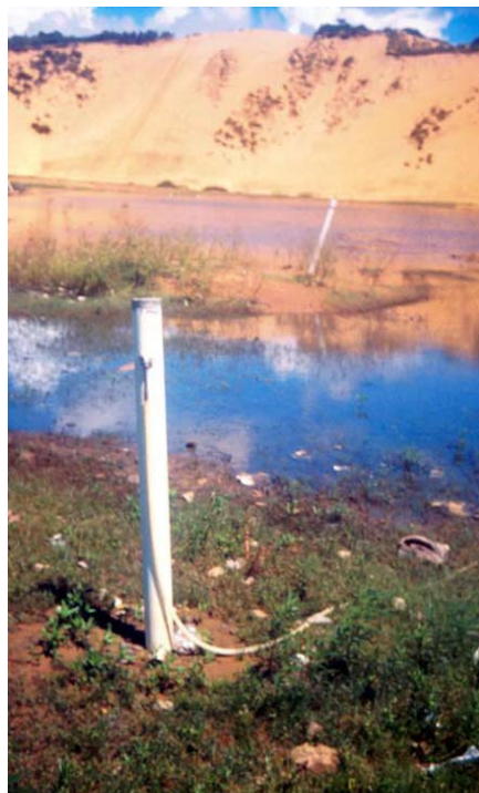
Figura13 – Captação do Biogás
