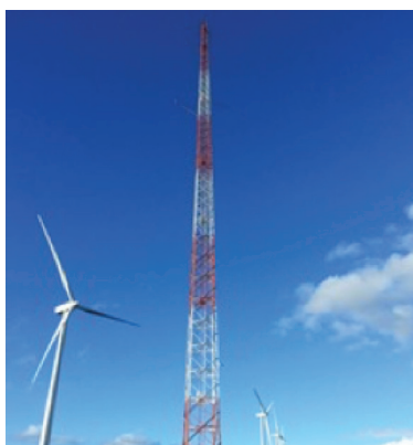
Figura 2a. Torre autoportante.
