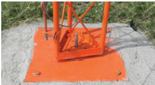
Figura 15a. Fixação do primeiro módulo por sistema tipo rótula.
