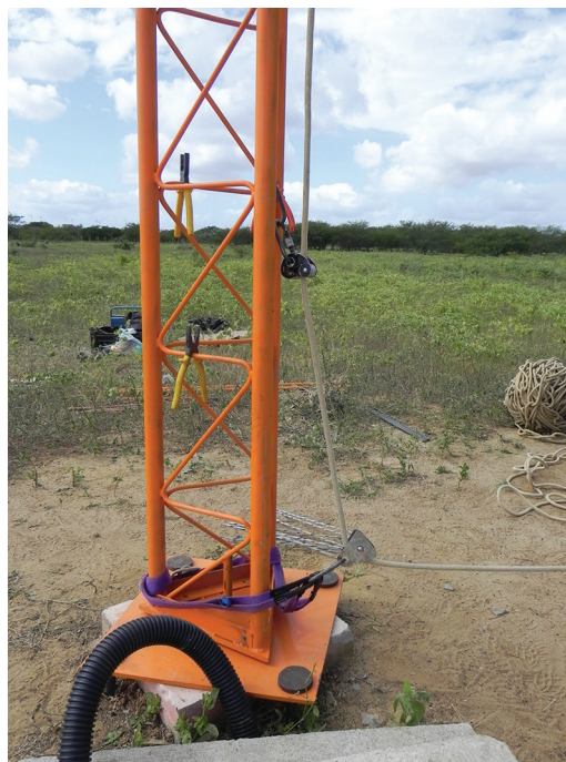
Figura 29. Roldanas para içamento.
