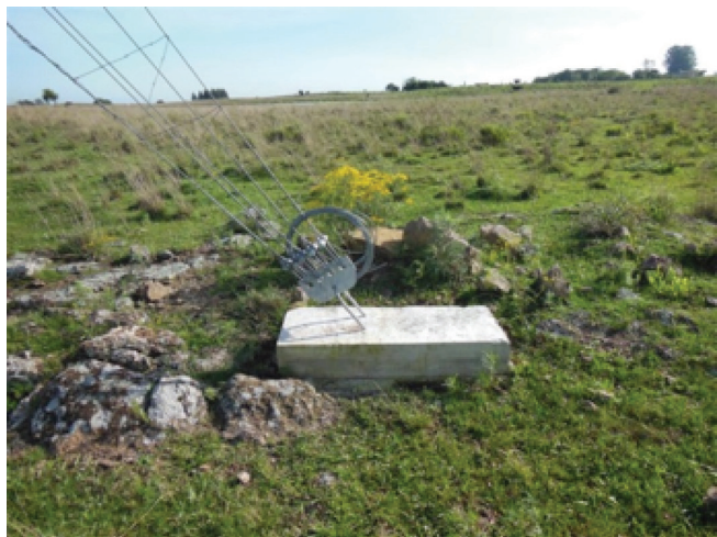
Figura 21. Dois exemplos de ancoragem por meio de blocos de concreto.
