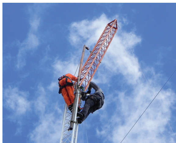
Figura 32. Assentamento da face dos módulos.
