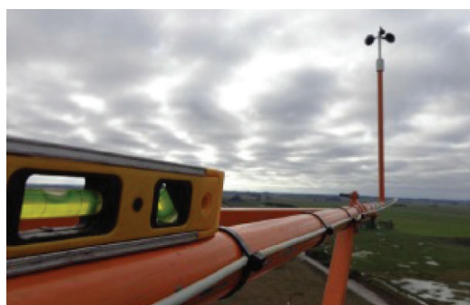
Figura 66b. Verificação do nivelamento.
