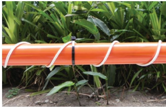
Figura 63. Cabo fixado com presilha plástica preta.
