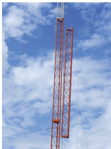
Figura 31. Módulos sendo içados.
