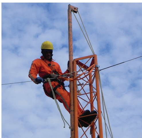
Figura 27. Torrista auxiliando a suspensão do módulo.
