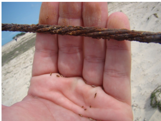
Figura 81. Estai oxidado por ação da maresia.
