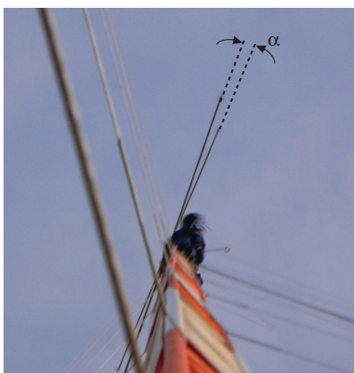
Figura 69a. Hastes desalinhadas.
