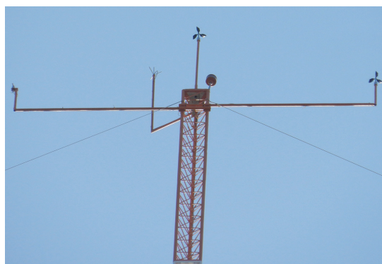
Figura 49. Topo de uma torre com instrumentos instalados.
