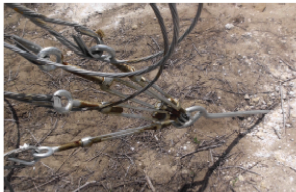
Figura 22b. Exemplo de ancoragem tipo trado.
