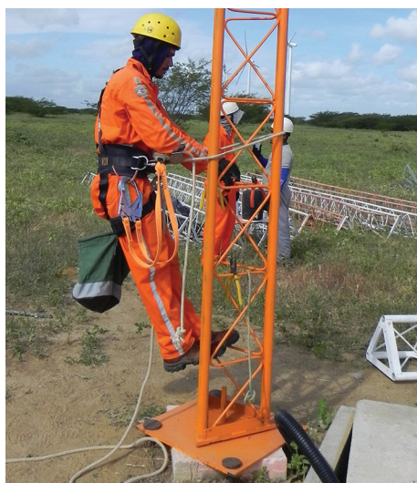
Figura 84. Torrista utilizando EPI.
