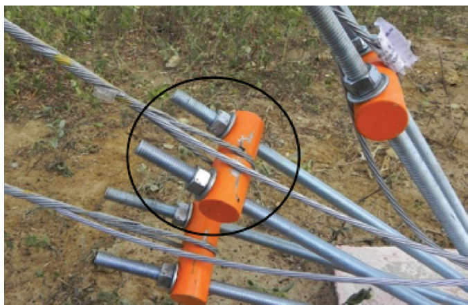
Figura 17b. Detalhes da fixação.
