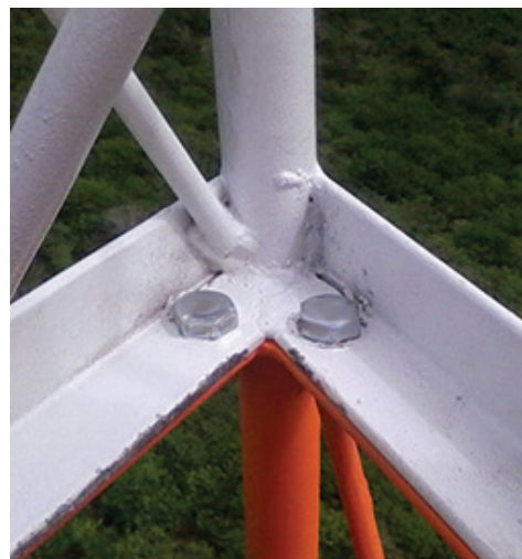
Figura 34. Módulos aparafusados e alinhados.
