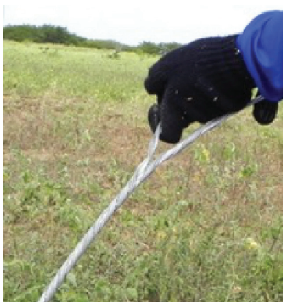
Figura 17a. Colocação da alça no estai.
