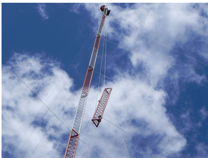
Figura 30. Módulo sendo içado.
