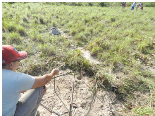
Figura 11. Marcação dos estais.
