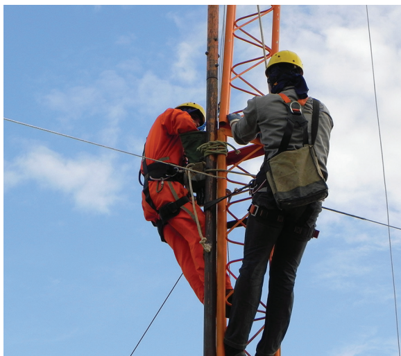
Figura 33. Torristas fixando os parafusos de fixação.
