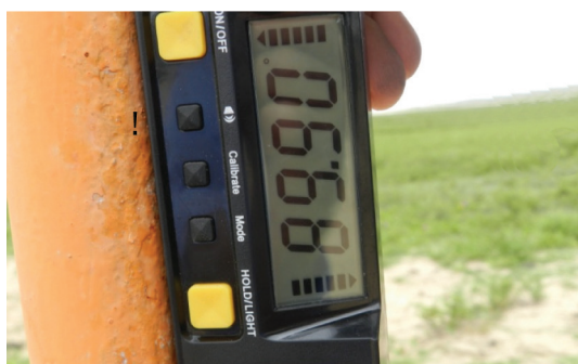
Figura 66a. Verificação de verticalidade.
