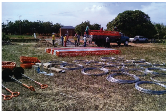
Figura 7. Distribuição do material no local da instalação.
