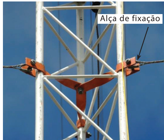
Figura 20. Alças de fixação dos estais na torre.
