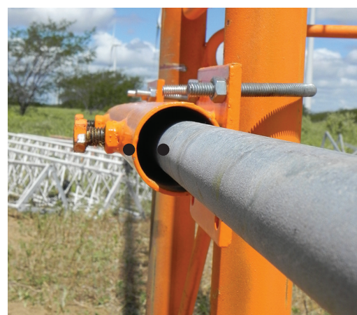
Figura 61. Alinhamento do suporte horizontal fixado à torre com sua respectiva haste horizontal.
