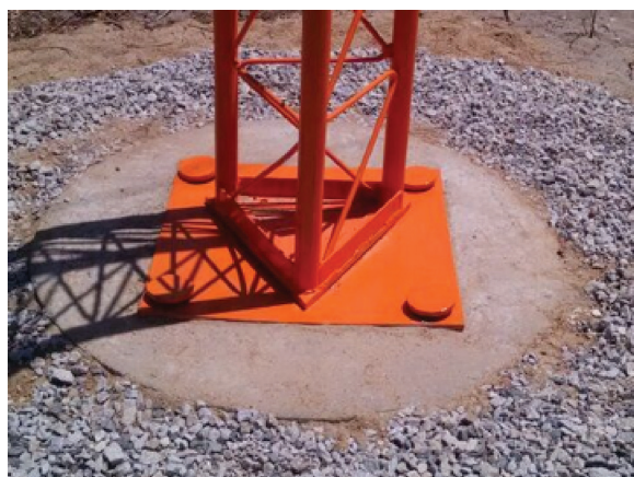
Figura 13. Duas montagens de base em estrutura de concreto.
