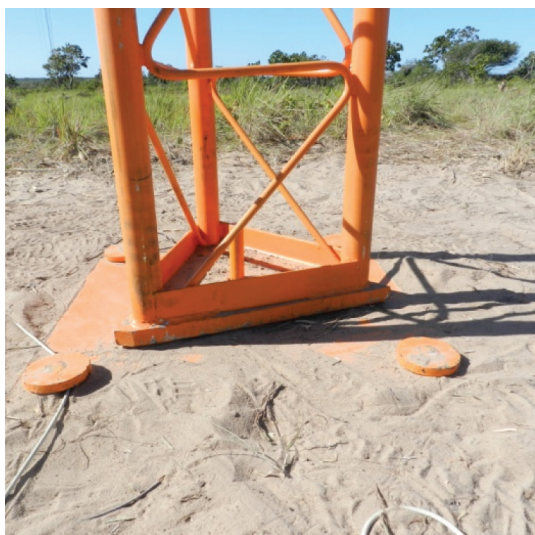
Figura 12a. Fixação em base de aço.
