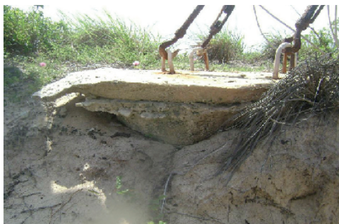
Figura 23. Ancoragem tipo concreto em solo arenoso.
