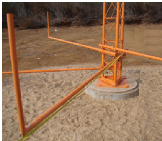
Figura 57. Hastes horizontais, verticais e respectivos suportes instalados na base da torre.
