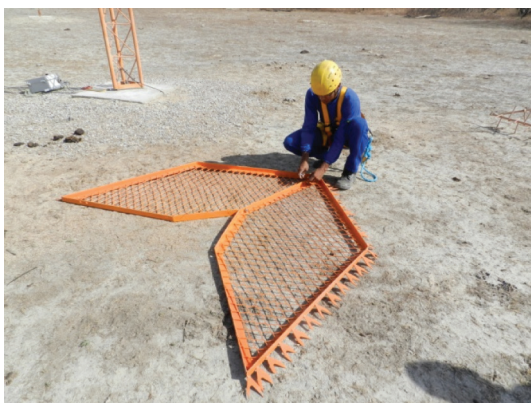
Figura 39a. Inibidor de escalada montado.
