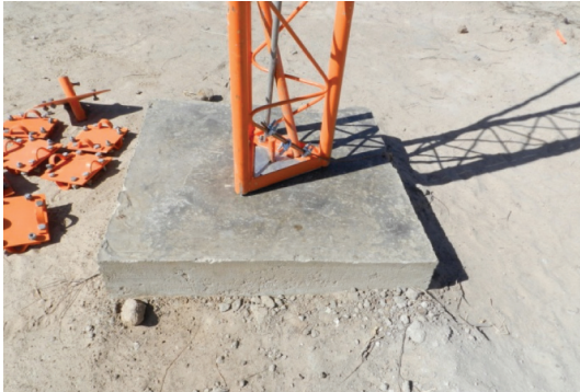
Figura 14a. Fixação do primeiro módulo da torre na base por sistema fixo.
