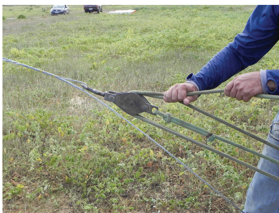
Figura 35. Alinhamento pelo tensionamento dos estais por meio dos moitões.
