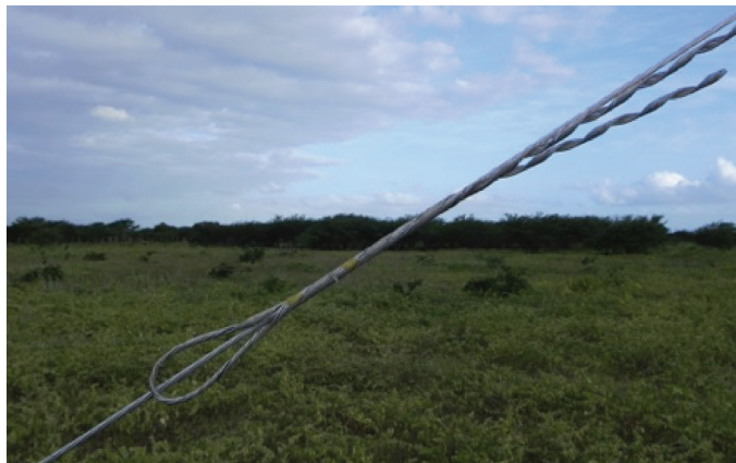
Figura 16. Detalhes de fixação da alça de ancoragem.
