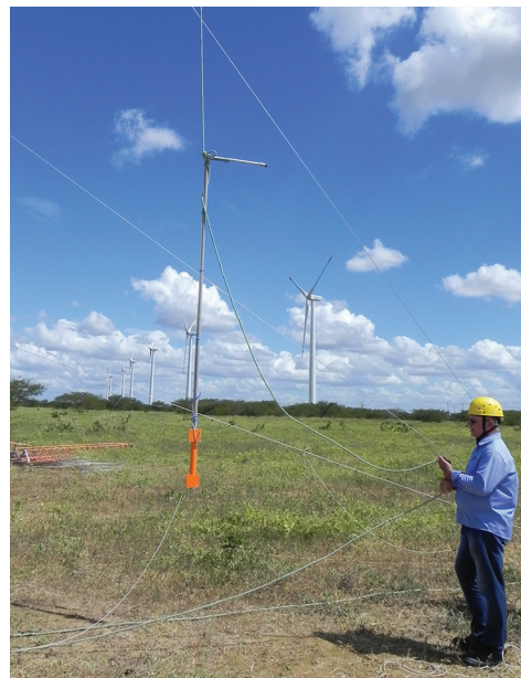
Figura 65. Içamento de haste do sensor.
