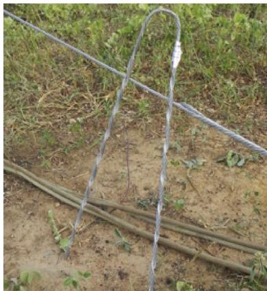
Figura 16. Detalhes de fixação da alça de ancoragem.
